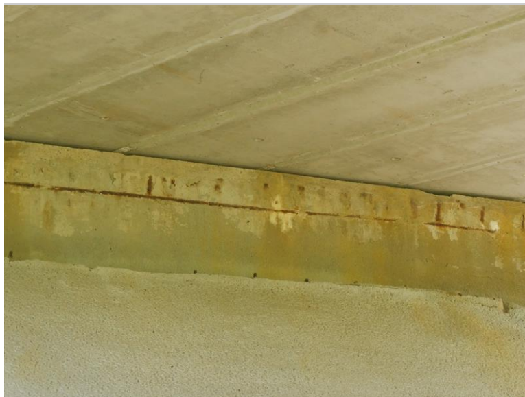
ÚP OP1 korozní šmouhy, vodorovná spára mezi opěrou a ÚP
