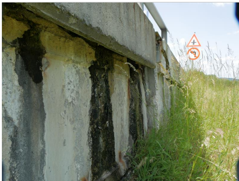
pravé křídlo OP4, zatékání z pod římsy
