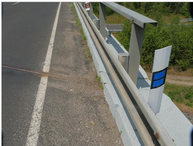
nečistoty v krajích u vozovky
