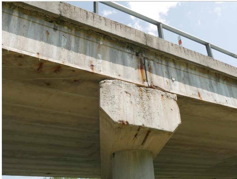
pohled vlevo na P2, koroze kotevní desky předpětí levého krajního nosníku pole 1
