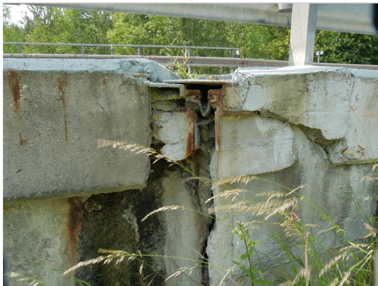
detail MZ vpravo na římse, poruchy betonové římky, koroze ocelových profilů MZ
