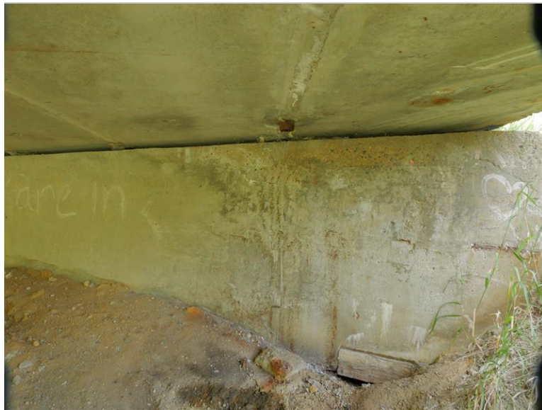
pravá strana OP4 - poruchy zemního tělesa
