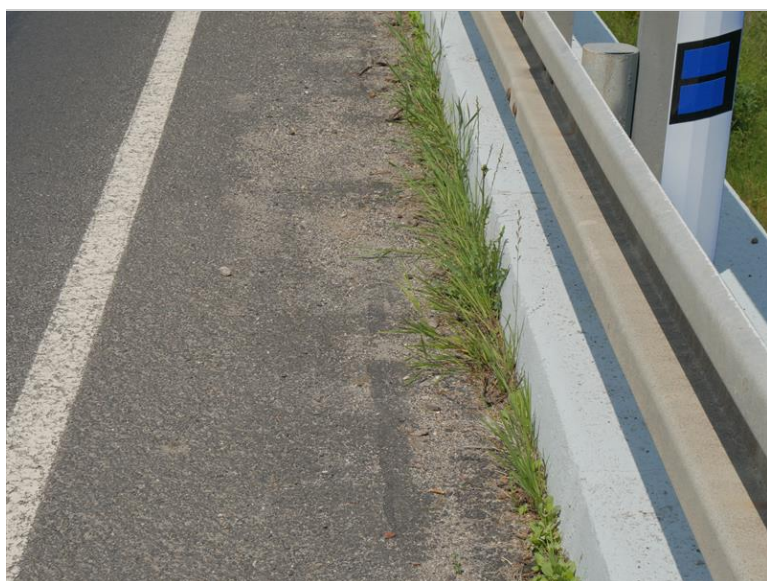
drobná vegetace ve vozovce u římsy
