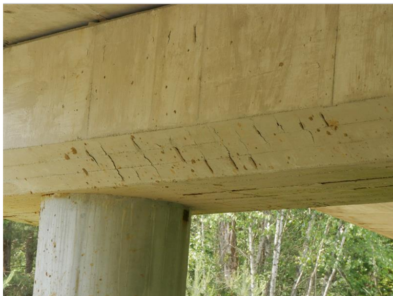
trhliny v místě nedostatečného krytí staviva P3
