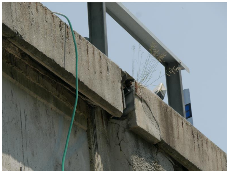
poruchy v ochranné omítce římsy vlevo, uchycená vegetace v MZ vlevo
