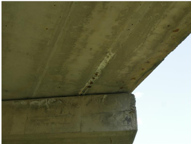
výtluky cementového mléka ve spáře mezi nosníky v 1.poli
