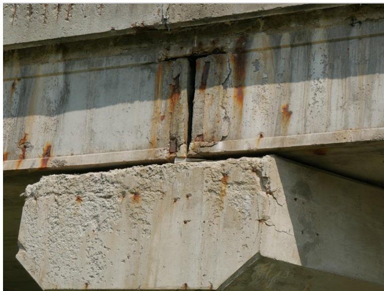
uložení na P3 vlevo - kotevní deska levého nosníku pole 3
