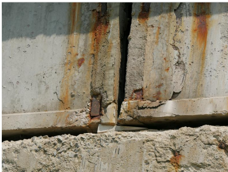
detail, poruchy čela nosníku vlevo pole 2
