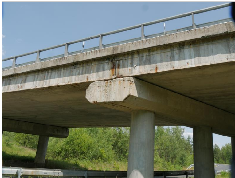
pohled na P2 zleva, zatékání z pod římsy
