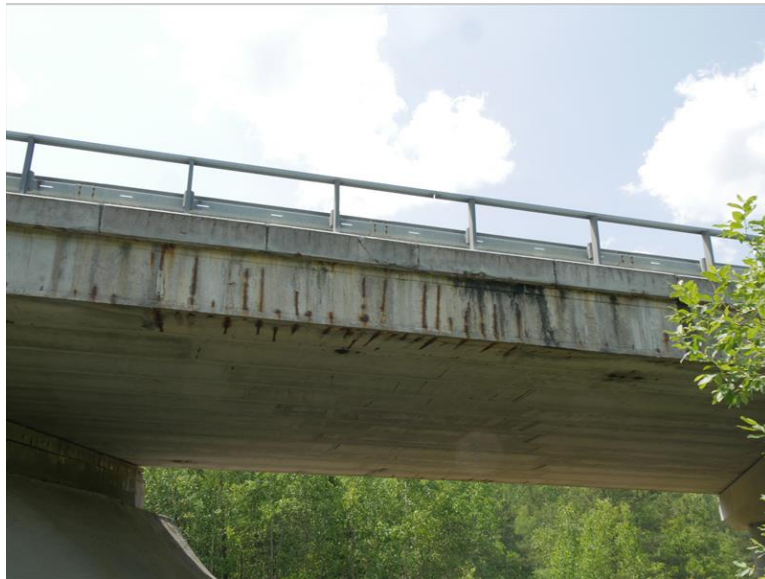
zatékání z pod římsy vpravo pole č.1, korozní šmouhy
