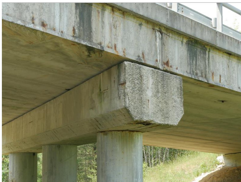
uložení na P3 vpravo, zatékání z pod římsy, rezavé šmouhy ve stěně nosníků vpravo
