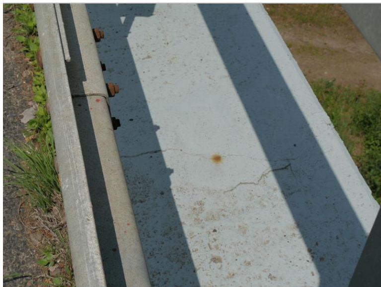
poruchy v sanační omítce římsy vpravo, koroze spojovacích prvků svodnice
