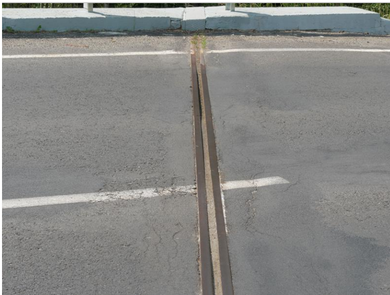
nečistoty v povrchu MZ OP4
