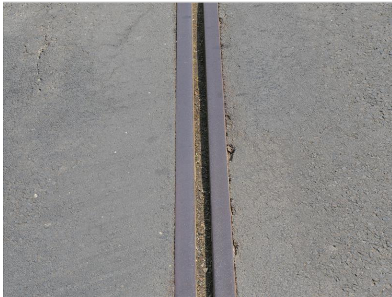
netěsná spára ve vozovce MZ OP4
