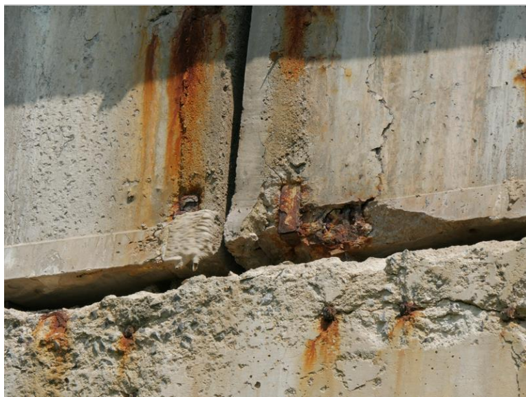
koroze kotevní desky předpínací výztuže v krajním pravém nosníku pole 1
