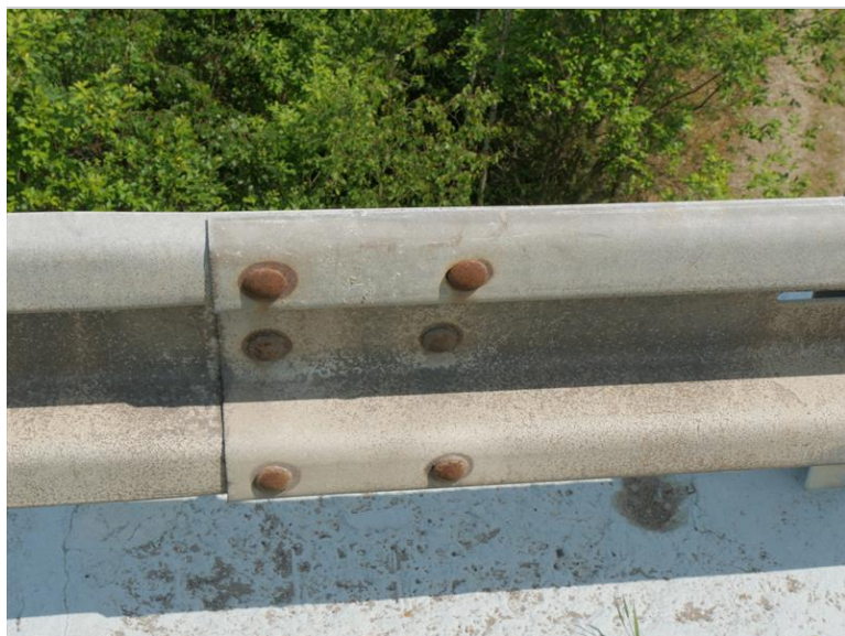
koroze spojovacích prvků svodnice
